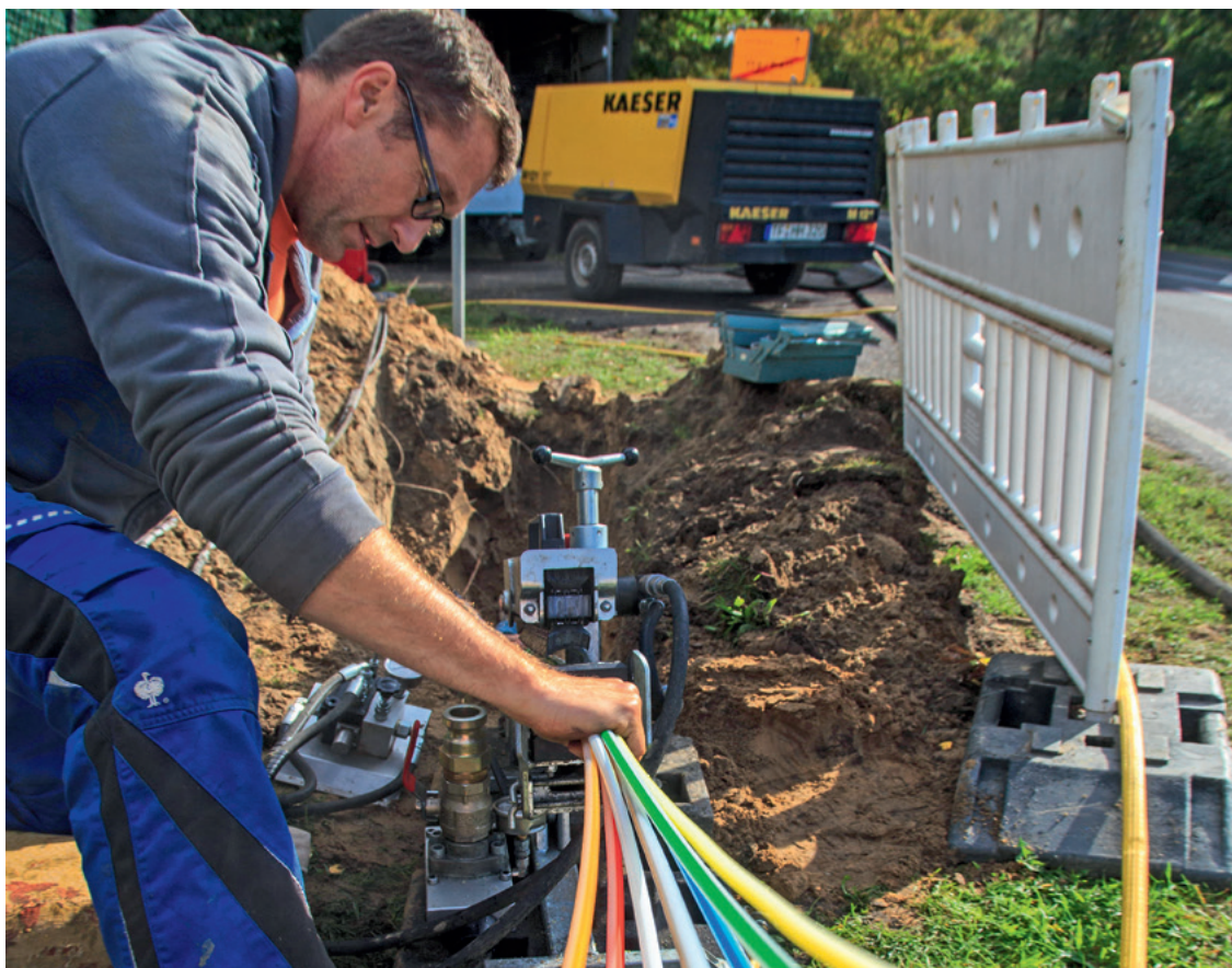
Ostprignitz-Ruppin: Leerrohre für Glasfaserkabel werden in ein dickes Erdkabel eingeführt und im Anschluss mit Lichtleiterbündeln versehen. Brandenburg wird den Glasfaserausbau in den kommenden Jahren weiter vorantreiben.
